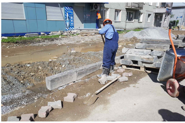
인도 보수공사 전경
