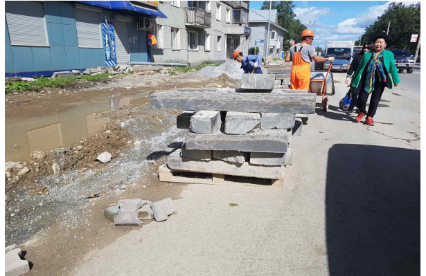
인도 보수공사 - 경계석 재활용
